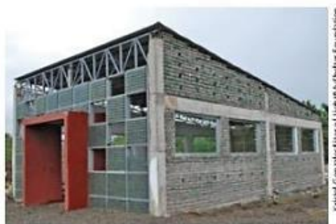
► Bottle School – projeto da Fundação My Shelter –, escola construída com garrafas de plástico PET preenchidas com terra e cimento em San Pablo, Laguna, Filipinas, 2011.
